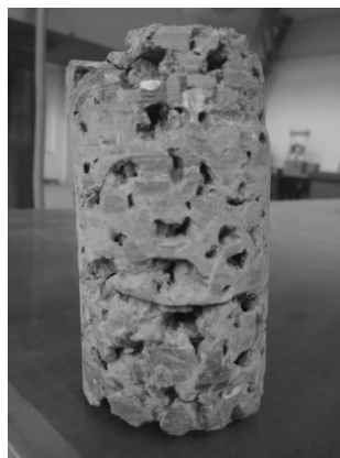
图 2 透水混凝土面层钻芯取样
