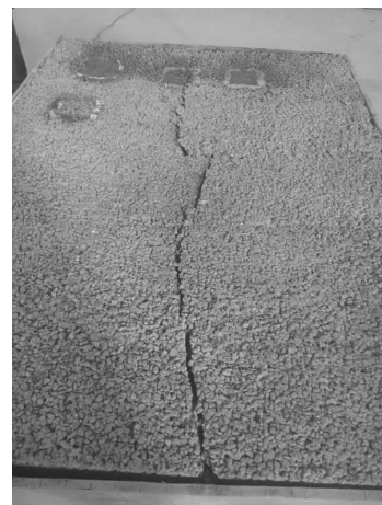
图 8 水饱和土基层透水混凝土面层裂缝形态
